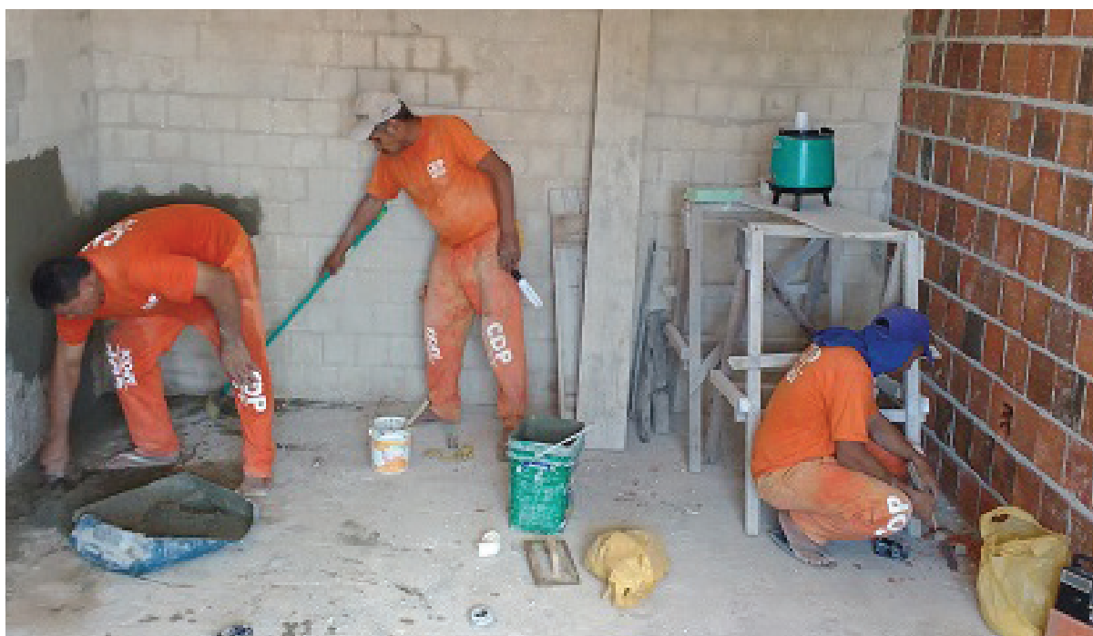
A equipe é formada por quatro pessoas e já contruiu salas, um novo centro cirúrgico, além de trabalhos em alvenaria, instalação elétrica
